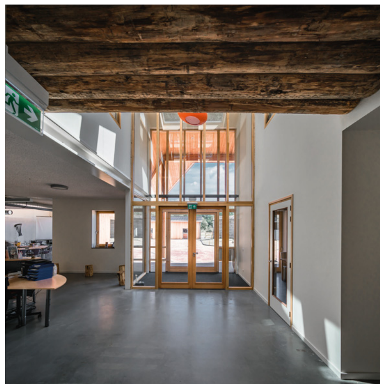
Onderkant van de rondhouten loopbrug in de entreehal.
